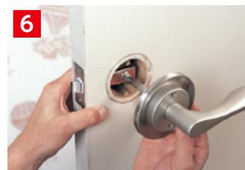
ハンドルの水平を確認しながら、内・外側丸座をネジ止めします。
