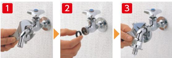
1 水道の元栓を閉めてから、スパナで自在パイプをはずし、パッキンを取り出します。
