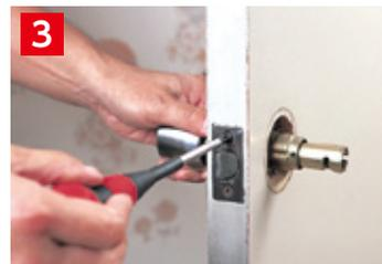
ドア側面のフロント板のネジをはずして、ラッチを引き抜きます。
