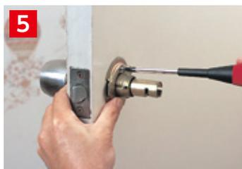
丸座を付けた後、内・外側丸座をネジ止めします。
