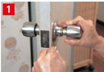
内側ノブの付け根部分の小さな穴に、目打ちや突き棒を差し込んで押しながら、ノブを引いてはずします。
