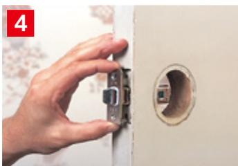
ラッチボルトの向きを確認し、新しいラッチを取り付けます。
