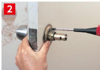
丸座をはずした後、丸座裏金のネジをはずして、内側の裏金をはずします。
