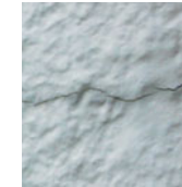
ひび割れ・欠け
